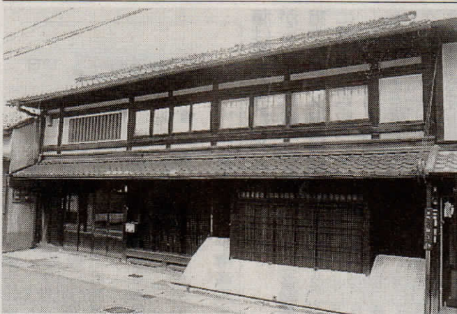
北川家住宅主屋（大津市京町1丁目）—滋賀県教委提供
